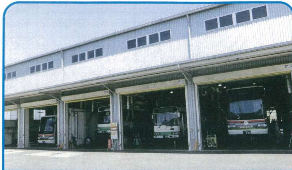
工場内冷暖房設備完備
